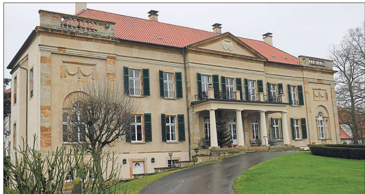
Die Sanierungs- und Restaurierungsarbeiten des Herrenhauses Harkotten mitsamt der Kapelle sind schon sehr weit gediehen.
